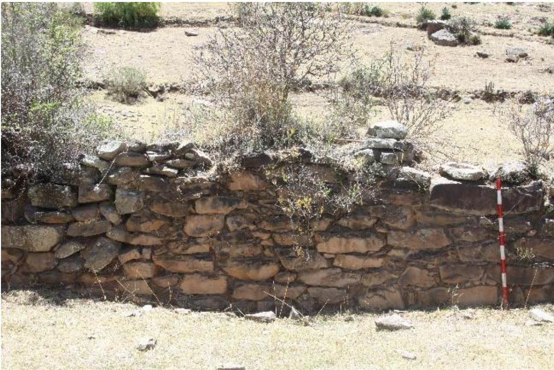
Foto 17.- Detalle de aparejo de los muros del Sector Colcaraccay (Fuente: Qhapaq Ñan).
