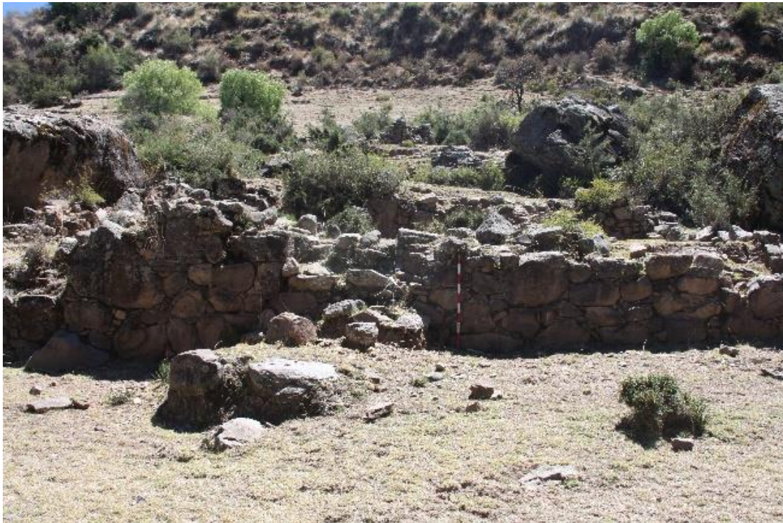
Foto 13.- Vista de estructura rectangular identificada al pie del camino (Fuente: Qhapaq Ñan).
