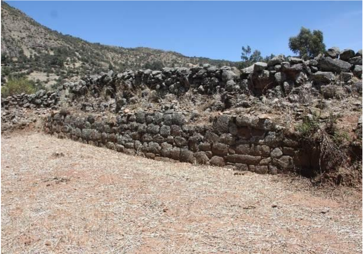
Foto 10.- Detalle del paramento de las estructuras del Sector Residencial (Fuente: Qhapaq Ñan).
