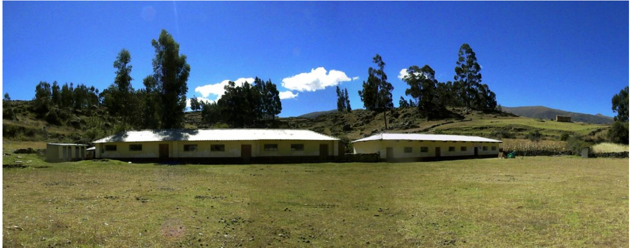
Foto 4.- Vista S-N en la que se visualizan las estructuras de un colegio al interior del polígono de Runayupana – Sector 1.
