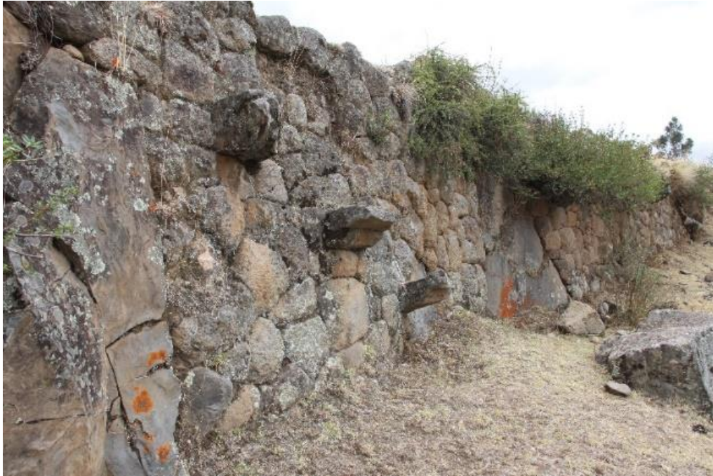
Foto 2.- Detalle del muro de contención y de los peldaños de Runayupana – Sector 1 (Fuente: Qhapaq Ñan).
