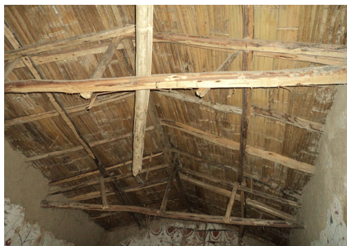
Vista de la estructura de la cobertura
