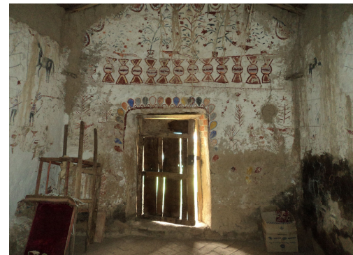
Nave vista hacia la puerta de ingreso
