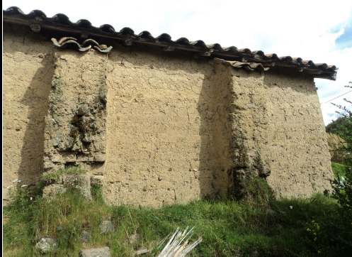
Fachada lateral (Muro de la espístola)
