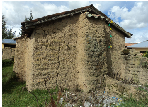
Fachada posterior ( Muro testero)
