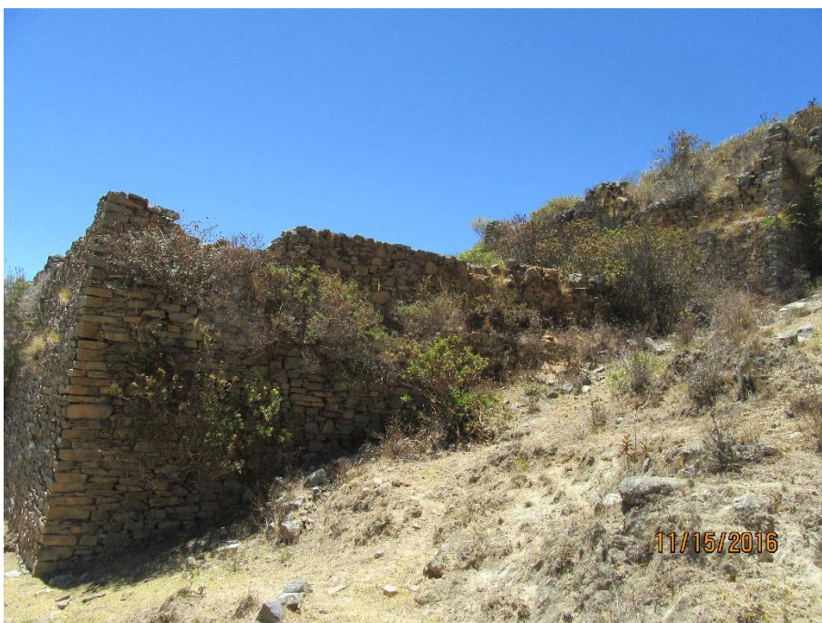
Foto N° 2. Vista semipañorámica de los recintos aterrazados mediante plataformas.
