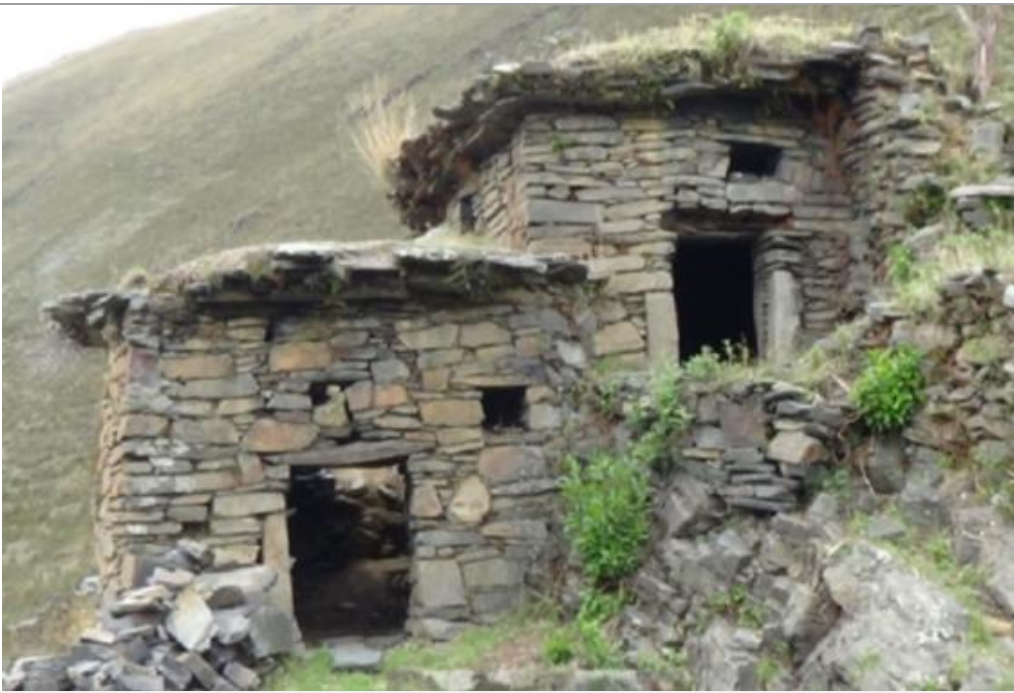
Foto N° 3. Vista en detalle de estructuras habitacionales (E-O).
