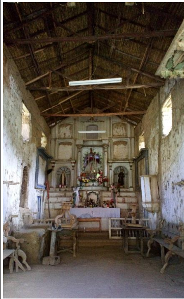
Nave de la Capilla
