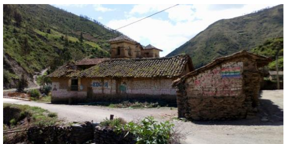
Hacienda: Crujía Sur y Crujía Este (Vista posterior)
