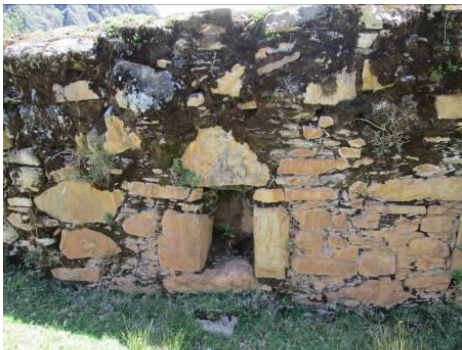
Foto N° 2. Detalle de las hornacinas registradas en el paramento exterior del muro que conforma la plaza principal.
