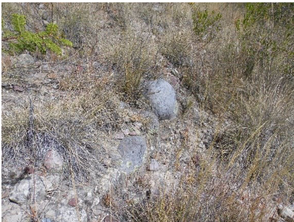
Fotografía 7. Cabecera de muro de contención de terraza (Coordenada referencial E587752 N8556934)
