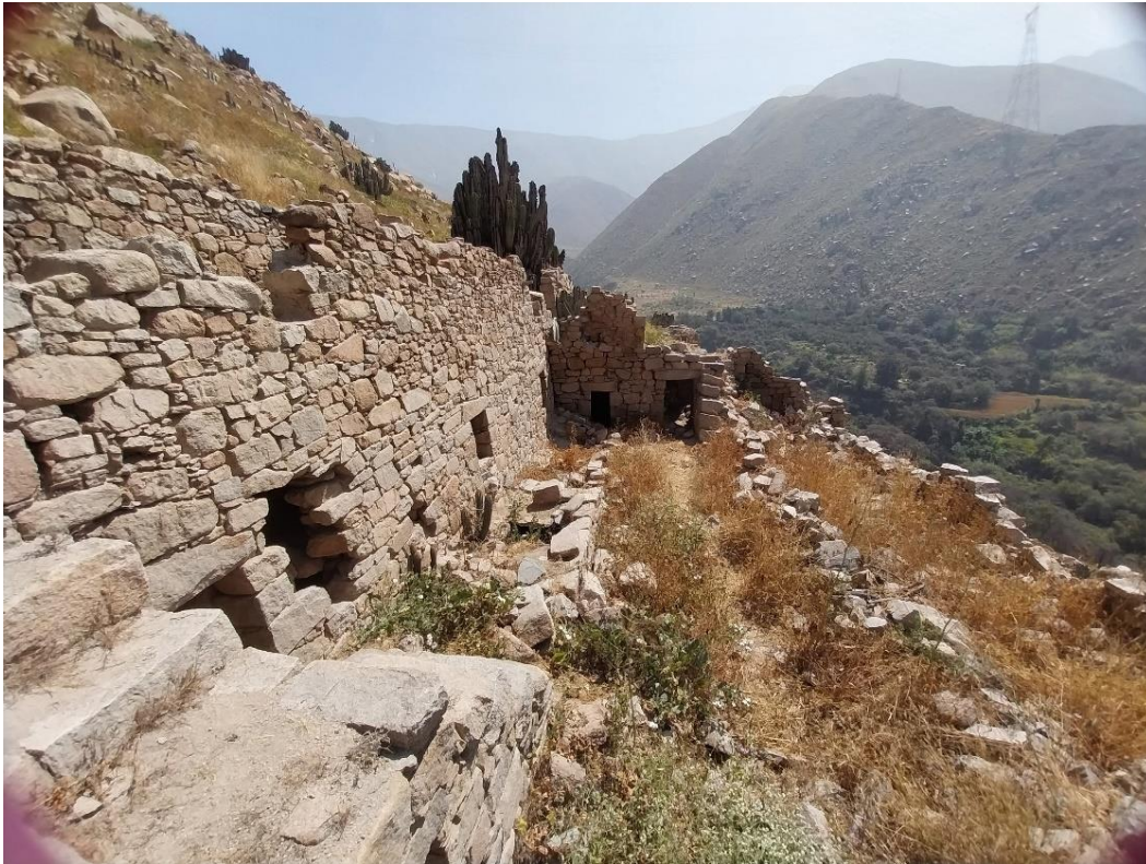
vista en detalle del edificio y la adaptación de las terrazas para su nivelación.
